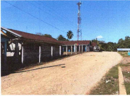
Foto 1: Se observa el deterioro del muro perimetral
